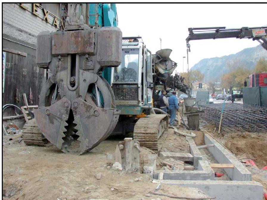
Fig. 6: Getto della paratia sul fronte strada; in primo piano la benna mordente per lo scavo a sezione obbligatoria
