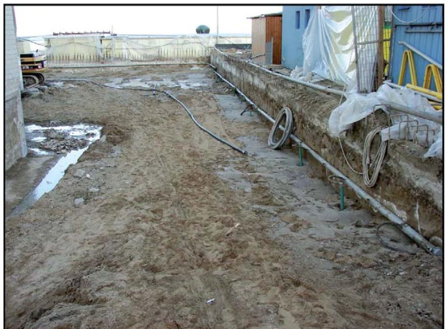
Fig. 9: Disposizione dell'impianto wellpoint
