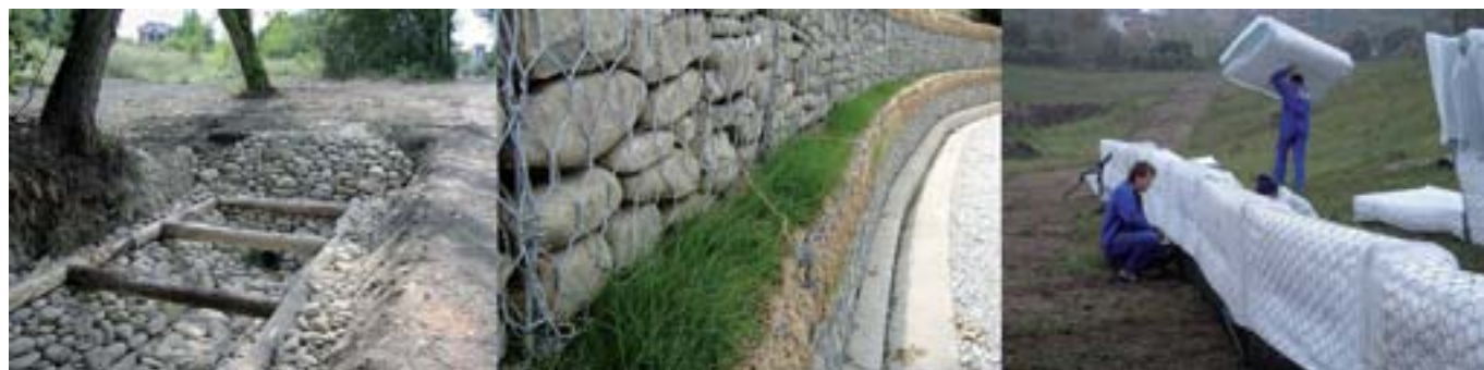
Fig. 2: Tecniche classiche e innovative: canalette in legname e pietrame, gabbionate rinverdibili, pannelli drenanti prefabbricati.
