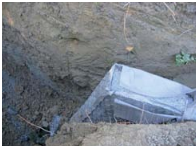
Fig. 6: La foto mostra la realizzazione della trincea drenante con profondità di circa 4 metri immersa sul piano indisturbato delle formazioni di base; si nota il pannello orizzontale con la guaina impermeabile di fondo in basso a sinistra e il camino drenante verticale che si eleva per due metri.
