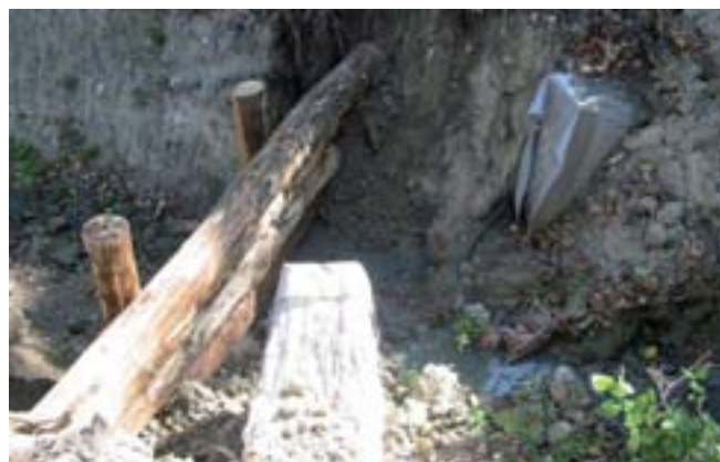
Fig. 5: La foto illustra la confluenza di due rami drenanti nel collettore centrale; lo spazio a monte e a valle dello sbarramento in legname verrà poi riempito con pietrame con finalità antierosive.
