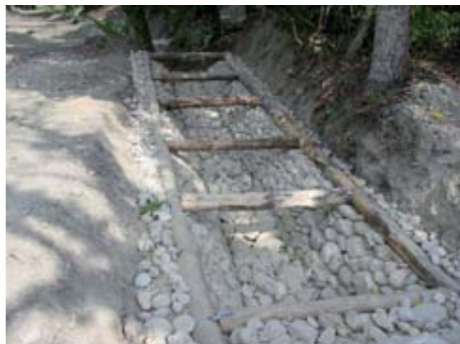
Fig. 7: Realizzazione di tecniche classiche di Ingegneria Naturalistica con canalette in pietrame e legname.
