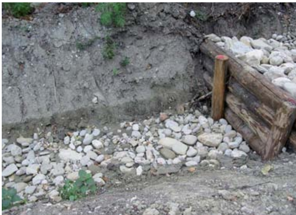
Fig. 8: Il collettore centrale come si presenta a fine lavori; il fosso rappresenta il recapito per il collettamento delle acque provenienti dalle trincee drenanti sub-superficiali e dalle canalette superficiali.
