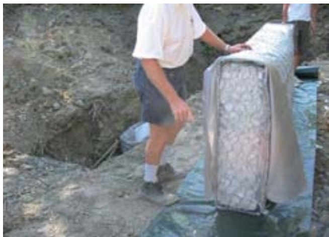
Fig. 3: Pannello drenante prefabbricato al di sopra della guaina impermeabile che funge da canaletta di fondo alla base.
