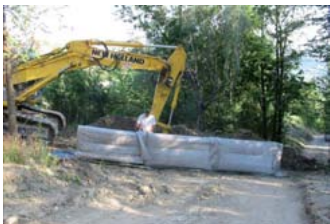
Fig. 4: Fasi di montaggio della linea drenante mediante legatura dei singoli pannelli.
