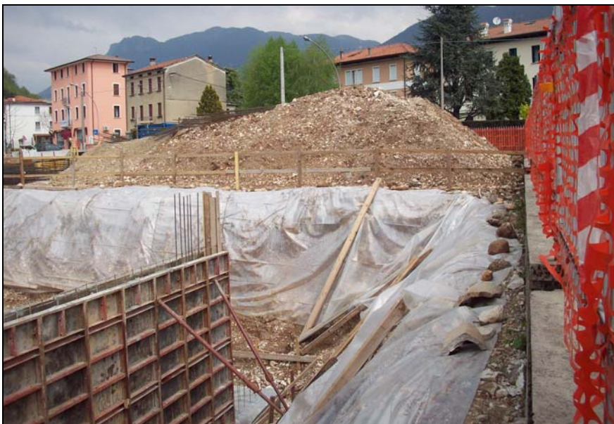
Foto 1 – Cumulo di materiale realizzato a ridosso di un fronte di scavo.
