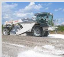
La tecnica dei trattamenti con calce delle terre ha ormai raggiunto anche in Italia un grado di perfezionamento e di esperienza tale da garantire ottimi risultati nel miglioramento delle caratteristiche di portanza delle opere in terra.
