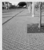
Sono marciapiedi o parcheggi che permettono alla pioggia di infiltrarsi attraverso la superficie pavimentata in uno strato di raccolta inferiore, dove l'acqua è contenuta prima di essere infiltrata nel terreno, riutilizzata, o rilasciata ad altri dispositivi drenanti.
