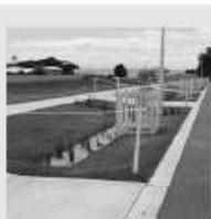
Sono formati da zone depresse lineari di vegetazioni che raccolgono flussi d'acqua da zone impermeabili. Dove possibile, possono essere progettati in modo da consentire infiltrazioni. Possono sostituire i sistemi convenzionali di drenaggio dell'acqua.
