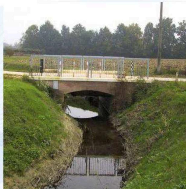
A LUCE NETTA = MANTENIMENTO DELLA SEZIONE IDRAULICA
