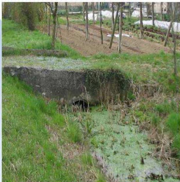
CON TUBAZIONE = DIFFICOLTA' DI DEFLUSSO - RIDUZIONE DELLA SEZIONE - DIFFICOLTA' DI PULIZIA
