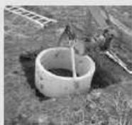
Sono cisterne sotterranee di forma quadrata o circolare che vengono alloggiate in contenitori di materiale plastico precedentemente inseriti nel terreno oppure ricoperte in terra battuta o in ghiaia. Possono essere collegate tra loro per il drenaggio di vaste aree aumentando la loro efficacia nella riduzione del rischio idraulico.
