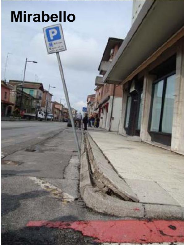
**Sisma Emilia 2012, esempi di danni in siti dove si sono verificati effetti di espansione laterale per liquefazione**
