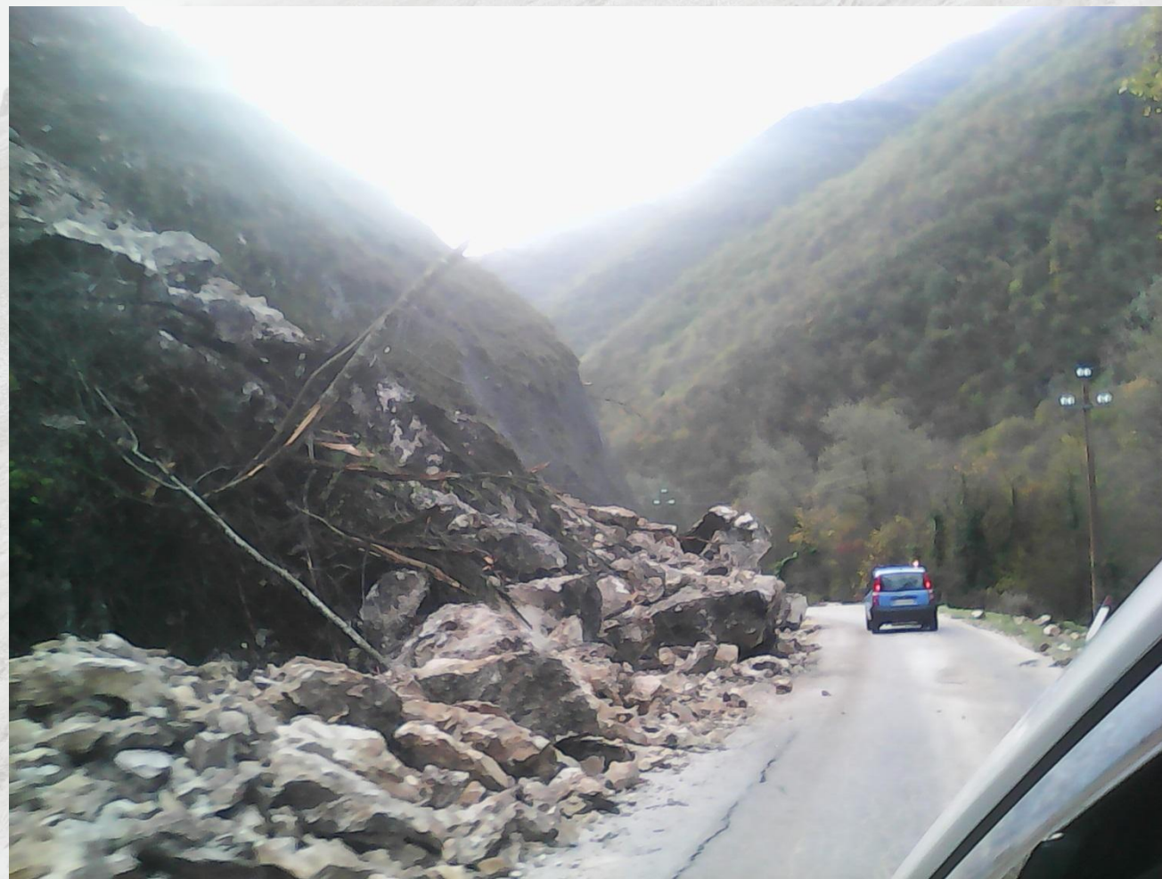
Crolli nel tratto stradale Visso-Castelsantangelo sul Nera
