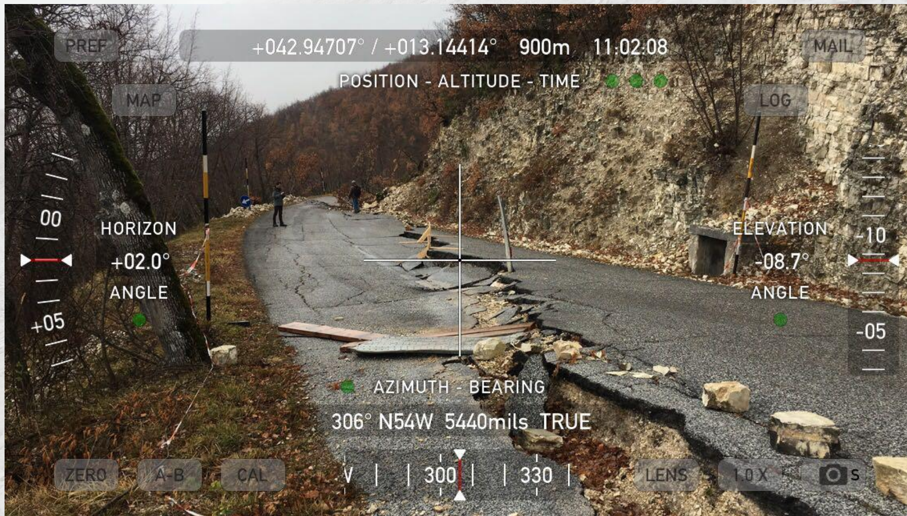
Tratto stradale Ussita-Casali
