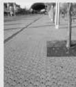
Sono marciapiedi o parcheggi che permettono alla pioggia di infiltrarsi attraverso la superficie pavimentata in uno strato di raccolta inferiore, dove l'acqua è contenuta prima di essere infiltrata nel terreno, riutilizzata, o rilasciata ad altri dispositivi drenanti.
