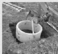
Sono cisterne sotterranee di forma quadrata o circolare che vengono alloggiate in contenitori di materiale plastico precedentemente inseriti nel terreno oppure ricoperte in terra battuta o in ghiaio. Possono essere collegate tra loro per il drenaggio di vaste aree aumentando la loro efficacia nella riduzione del rischio idraulico.
