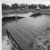
Sono dispositivi con un'alta capacità di detenzione che possono essere usati per creare sotto il terreno strutture in grado di contenere grandi quantità d'acqua o di permettere l'infiltrazione nel terreno.
