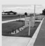
Sono formati da zone depresse lineari di vegetazioni che raccolgono flussi d'acqua da zone impermeabili. Dove possibile, possono essere progettati in modo da consentire infiltrazioni. Possono sostituire i sistemi convenzionali di drenaggio dell'acqua.
