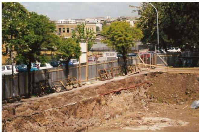
**FIGURA 4** - VIA VOLTERRA, ANNO 2001, DURANTE LE PRIME FASI DELLA COSTRUZIONE DEL PARCHEGGIO. SI NOTA LA PARATIA CHE HA INTERCETTATO E SOLLEVATO LA FALDA, LA CUI DIREZIONE DI FLUSSO (VERSO IL TEVERE) È ORTOGONALE ALLA PARATIA
