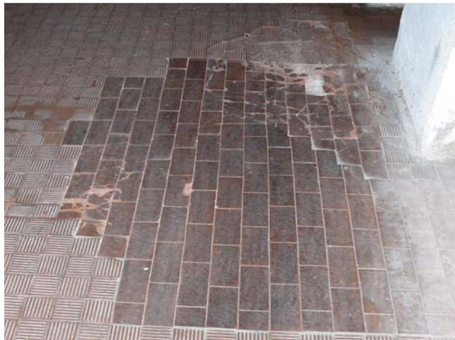
**FIGURA 7** - VIA VOLTERRA 26. APRILE 2010. ABBASSAMENTO DI PARTE DELLA PAVIMENTAZIONE DEL GARAGE, A FIANCO DI UN PILASTRO. VIENE INTERPRETATO COME EFFETTO DEL FENOMENO DI SIFONAMENTO DELLE PARTICELLE LIMOSO-SABBIOSE DA PARTE DEL FLUSSO IDRICO SOTTERRANEO LOCALMENTE ACCELERATO. QUESTO FENOMENO NON ERA PRESENTE NEL 2001
