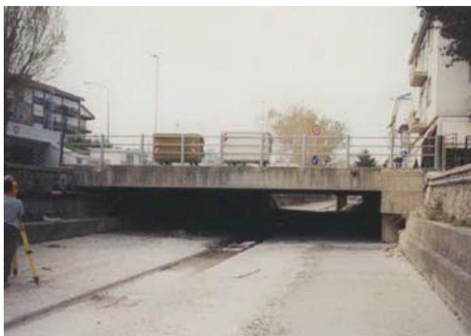
Il modello idraulico mostra dei punti critici, anche per bassi tempi di ritorno, in cui la superficie dell'acqua si posiziona al di sopra della livelletta degli argini. Per stimare le portate in esondazione generate dal rigurgito di un ponte, ma anche da una ridotta sezione in terra o da una deficienza arginale localizzata, si è deciso di procedere per successive approssimazioni in questo modo:
