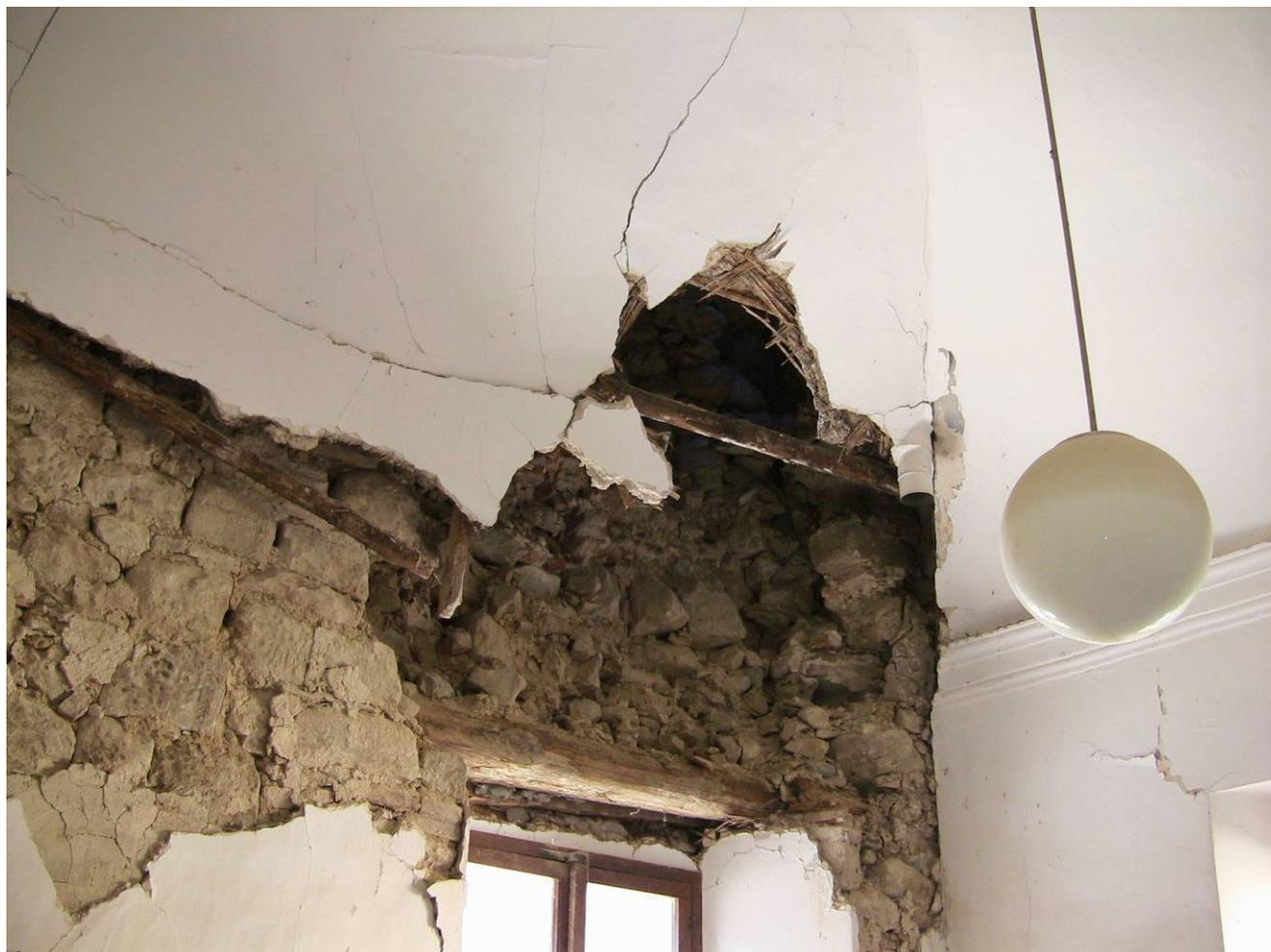
Foto 3 EDIFICIO PRINCIPALE - PARTICOLARE DEL MURO NELLA PARTE INTERNA IN CORRISPONDENZA DELLO SPANCIAMENTO ESTERNO
