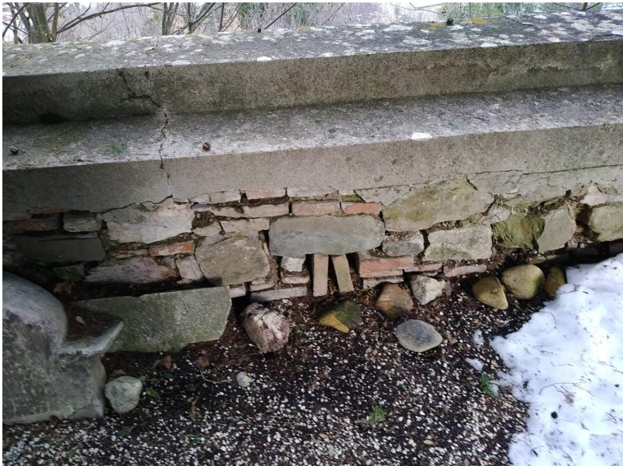
Foto 14 MURO DI RECINZIONE E DI CONTENIMENTO LESIONATO E CON PARTI MANCANTI
