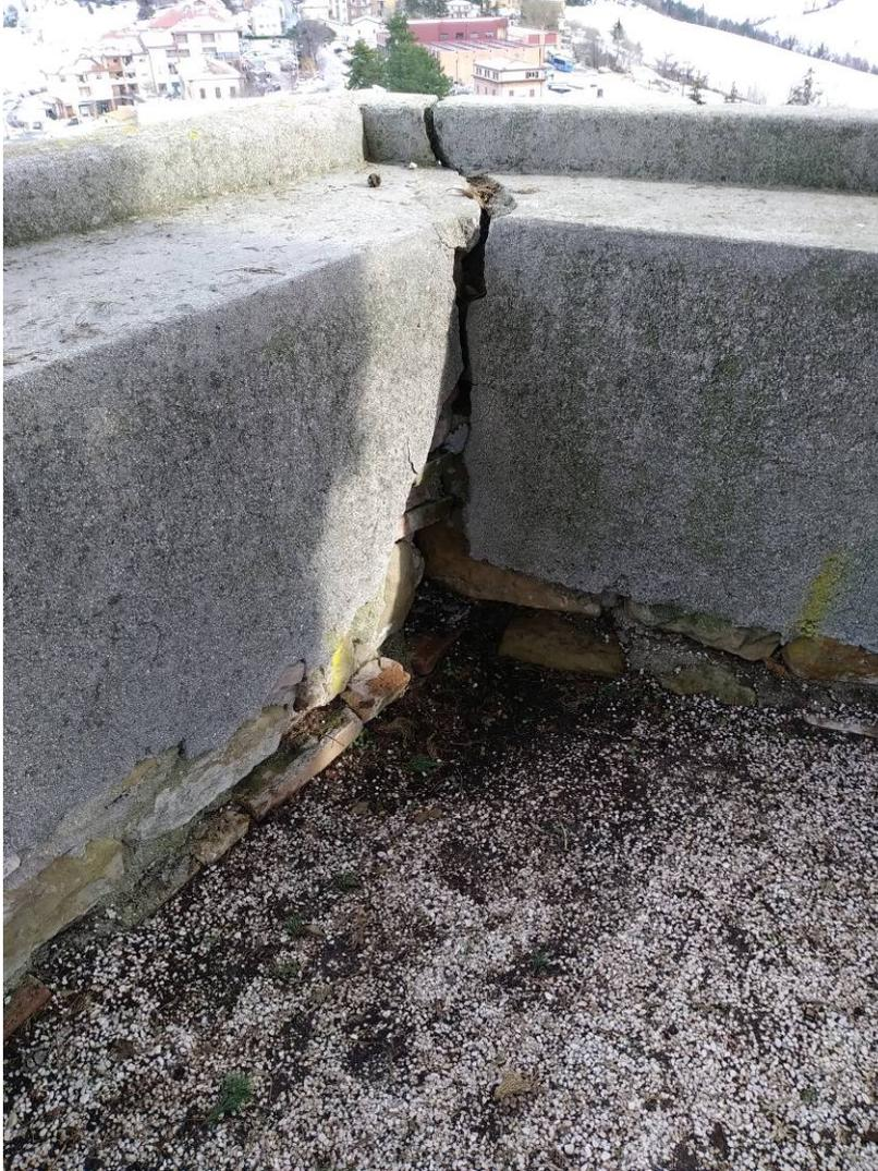
Foto 12 PARTICOLARE MURO DI RECINZIONE E CONTENIMENTO LESIONATO
