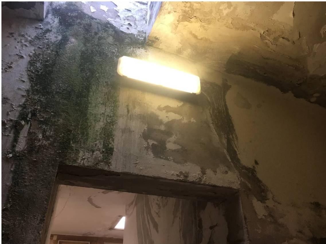
Foto 19 PADIGLIONE LOCULI (COSTRUZIONE 1)– INFILTRAZIONE DI ACQUA
