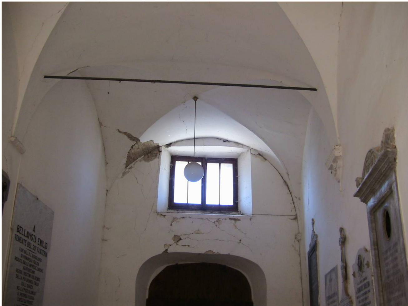
FOTO 10 EDIFICIO PRINCIPALE - LESIONI DIFFUSE LATO INGRESSO POSTERIORE DELL'EDIFICIO
