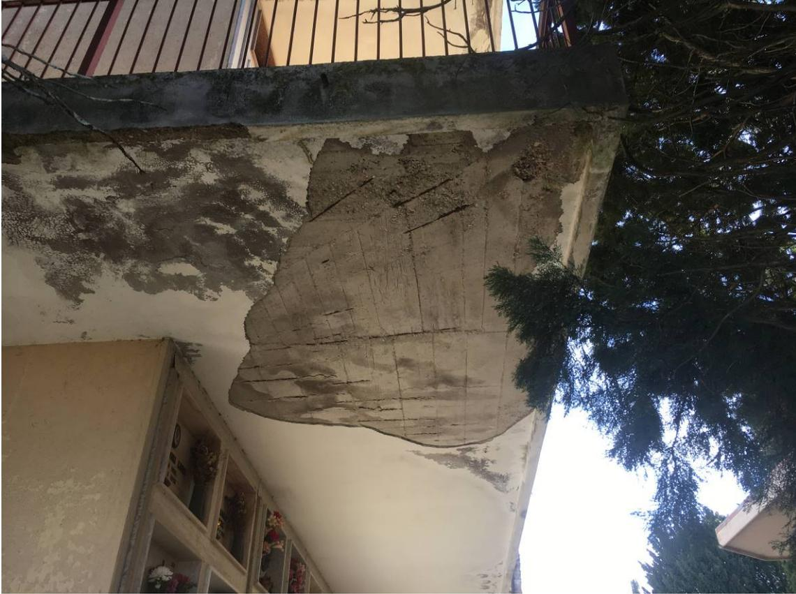
Foto 17 PADIGLIONE LOCULI (COSTRUZIONE 4) - STRUTTURE IN C.A. CON COPRIFERRO
