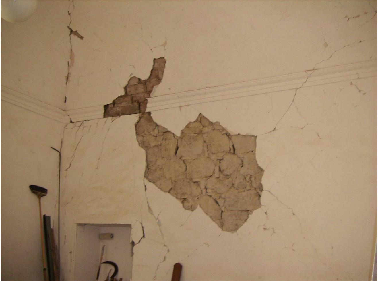
FOTO 8 EDIFICIO PRINCIPALE - ALTRA PARETE INTERNA LESIONATA CON DISTACCO DI INTONACO
