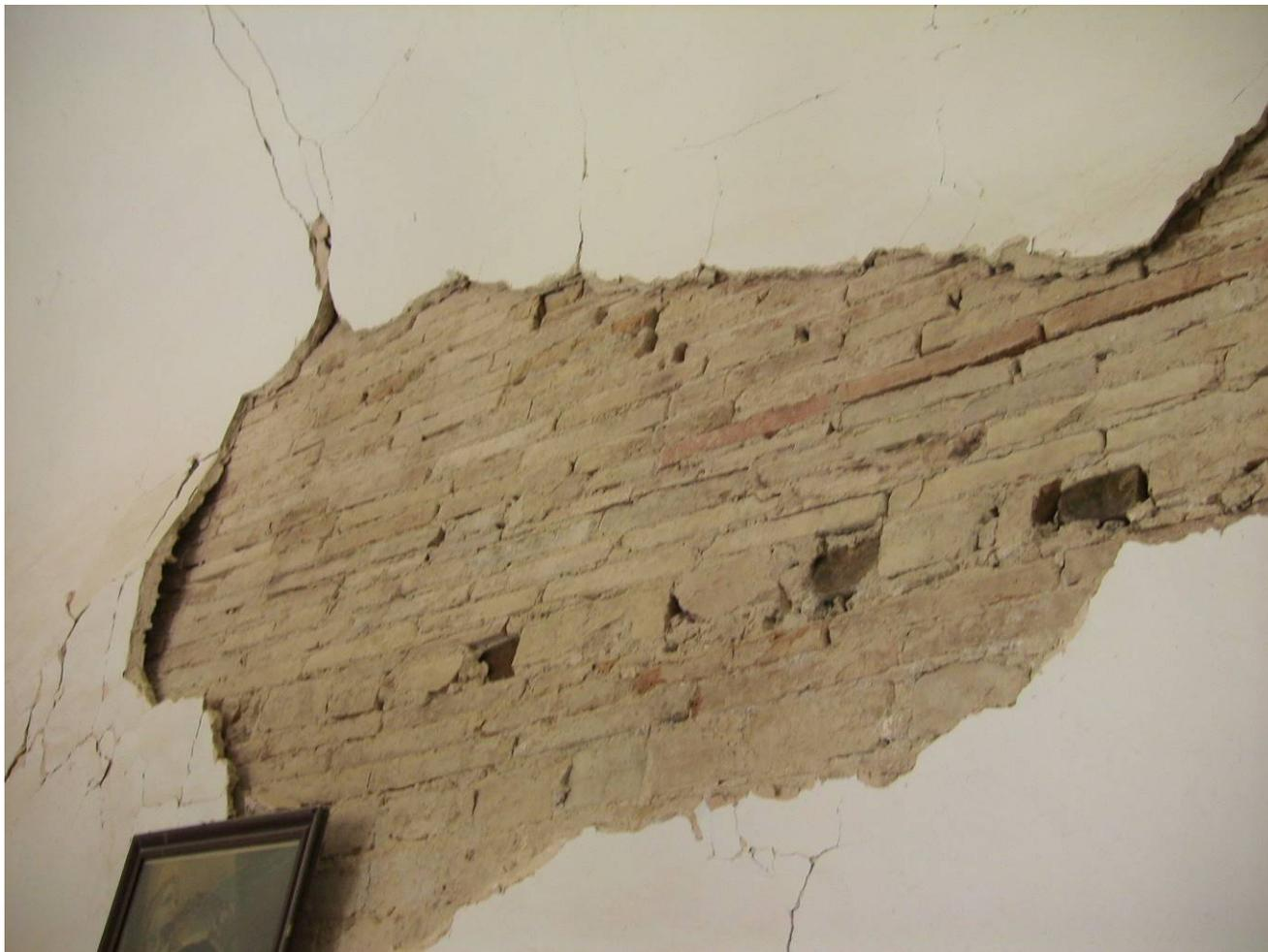
Foto 7 EDIFICIO PRINCIPALE - DISTACCO INTONACO CON LESIONI ALLA MURATURA IN MATTONI E PIETRA
