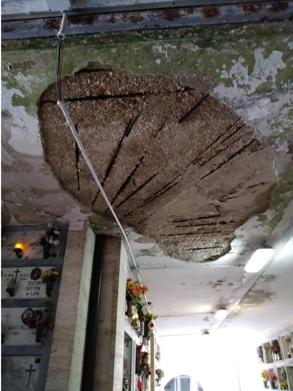
Foto 16 PADIGLIONE LOCULI (COSTRUZIONE 6) - STRUTTURE IN C.A. CON COPRIFERRO
