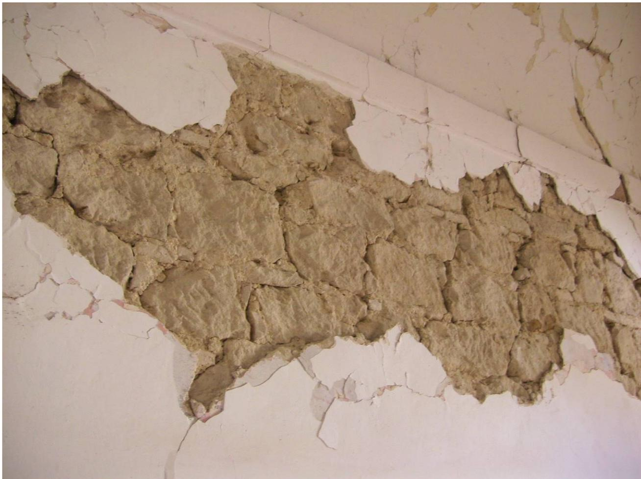
Foto 5 EDIFICIO PRINCIPALE - PARTICOLARE DI PORZIONE DELLA MURATURA INTERNA CON CADUTA DI INTONACO E MURATURA IN PIETRA LESIONATA
