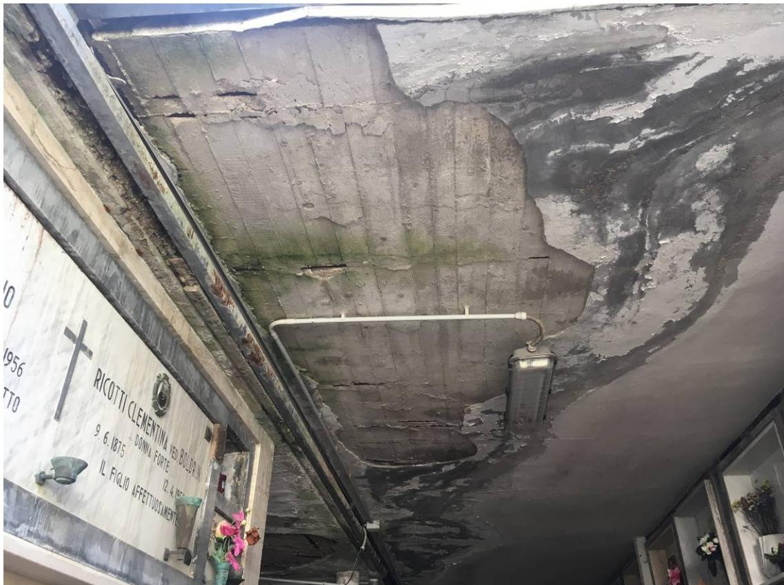
FOTO 18 PADIGLIONE LOCULI (COSTRUZIONE 6)–INFILTRAZIONE DI ACQUA
