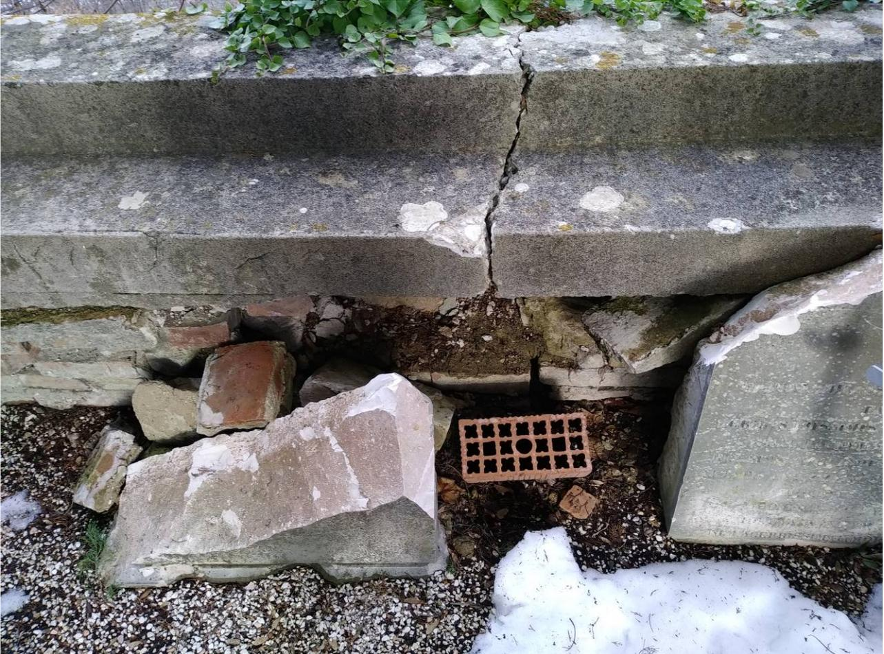
Foto 15 MURO DI RECINZIONE E DI CONTENIMENTO LESIONATO
