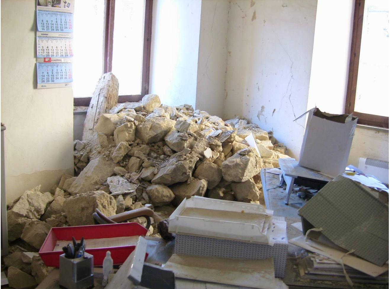
Foto 4 EDIFICIO PRINCIPALE - PARTE INTERNA SEMPRE RIFERITO ALLO SPANCIAMENTO ESTERNO CON CROLLO DI PARTE DEL PARAMENTO MURARIO SOPRA LA SCRIVANIA
