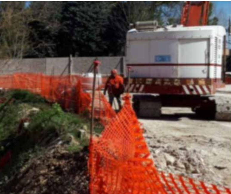
[...] L'ARTICOLO ANALIZZA LE PRINCIPALI TECNOLOGIE DISPONIBILI PER LA REALIZZAZIONE DI DIAFRAMMI PER LA MESSA IN SICUREZZA DI SITI INQUINATI O DI DISCARICHE, PUNTUALIZZANDONE ASPETTI SALIENTI, VANTAGGI E LIMITI. VENGONO TRATTATI PIÙ IN DETTAGLIO I DIAFRAMMI PLASTICI COSTITUITI DA MISCELE TERNARIE ACQUA-CEMENTO-BENTONITE (COSIDDETTI AUTOINDURENTI), PONENDO L'ACCENTO SU ASPETTI PECULIARI DELLA LORO PROGETTAZIONE E REALIZZAZIONE [...]
