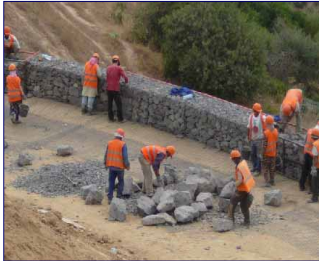
Spaccare massi sopra i rinforzi...
