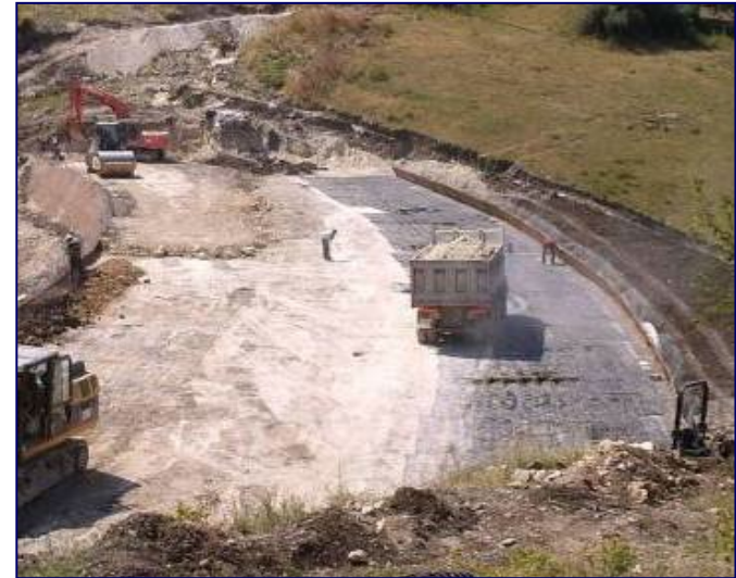
Transitare con i veicoli sopra i rinforzi...
