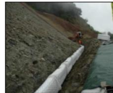
**MACDRAIN W:** geocomposito per drenaggio planare ottenuto da accoppiamento per termosaldatura continua di anima drenante in monofilamenti polimerici estrusi, sagomata secondo un profilo a canali paralleli, a due strati in geotessile avente funzione di separazione, filtrazione e protezione.
