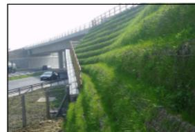
**GABBIODREN:** pannello drenante in rete metallica a doppia torsione rivestito internamente da un geotessile tessuto con funzione di filtrazione e separazione, il nucleo drenante è costituito da cubetti di polistirolo impurecibile, insolubile e chimicamente inerte alle acque.
