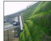
**MATERASSO RENO:** elementi in rete metallica a doppia torsione con maglia esagonale, tipo 6x6, tessuta con filo d'acciaio protetto con Galmac (lega Zn-Al 5%) e rivestimento PoliMac, altezza tra 0.17 e 0.30 m e tensione tangenziale ammissibile in condizioni di assenza di vegetazione tra 233 e 388 Nm<sup>2</sup>.
