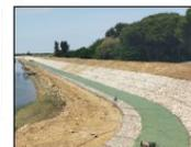
**PARADRAIN:** geogriglia con struttura planare costituita da due ordini di nastri di geotessili in poliestere ad alta tenacità che combinano funzioni di rinforzo e drenaggio, qui adatta a dissipare le sovrappressioni interstiziali generate in seguito alla compattazione.
