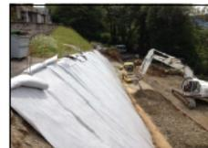
**MACMAT L1 40.14:** geocomposito costituito dall'accoppiamento mediante processo termico di una geotessitura a struttura tridimensionale a forma biconica ottenuta per estrusione di filamenti vergini di polipropilene con una membrana impermeabile protetta, da un lato, da un geotessile non tessuto.
