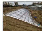
**MACMAT HS MO:** geocomposito anti-intrusivo e antierosivo formato da rete metallica doppia torsione tipo EX10, tessuta con filo dracolato con rivestimento in Polimak, diametro 2,7 - 3,7 mm, compenetrata a geostuola polimerica tridimensionale. Bordo esterno alla rete con tulle di diametro 6,0 - 8,0 mm.
