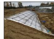
**GABBIONI:** elementi scartolari realizzati con rete metallica a doppia torsione con maglia esagonale, tipo BarD, tessuta con filo d'acciaio protetto con Galmac (lega Zn-Al 5%) e rivestimento PoliMac, diametro 2.7/3.7 mm.
