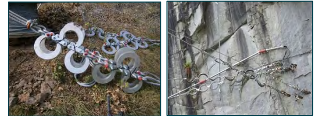
Dissipatori di energia
