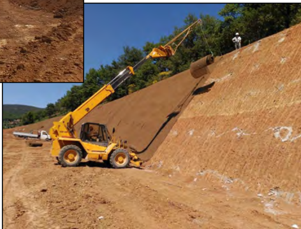
Rivestimento anti-erosivo ad elevata rigidezza di scavi definitivi
