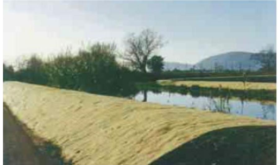
Costituita da una biostuoia (biofeltro, biorete), fissata al terreno mediante picchetti metallici, eventualmente abbinata a idrosemina, posa di talee piantagione di arbusti.
