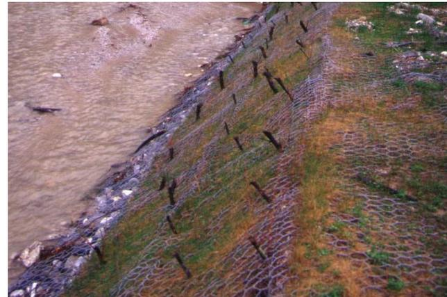
Materassi foderati all'interno con stuoie sintetiche o in fibra vegetale con funzione di filtro e ritenzione.
