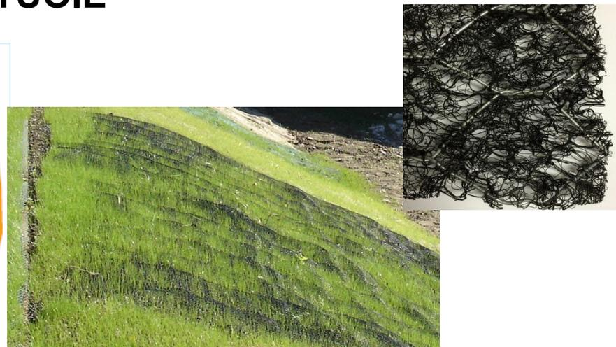
Rivestimento di sponde soggette a erosione mediante la stesa di una stuoia sintetica tridimensionale, spessore min. 10 mm, eventualmente rinforzate da una rete metallica a doppia torsione.
