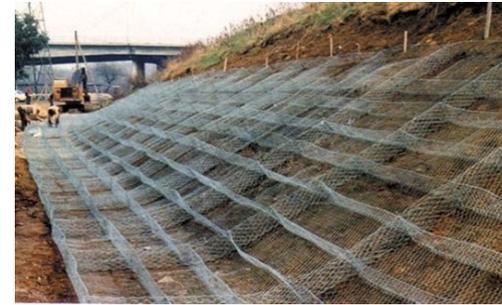
Una protezione contro l'erosione mediante strutture caratterizzate da una elevata resistenza alle azioni di trascinamento della corrente, può essere garantita da scatolari in rete metallica a doppia torsione, riempiti di pietrame di idonea pezzatura.
