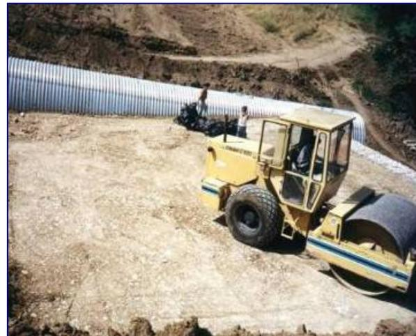
Nel caso di utilizzo di terreni di riempimento particolari (per dimensioni, aggressività, etc.) sono necessari test specifici per procedere con una progettazione adeguata.
