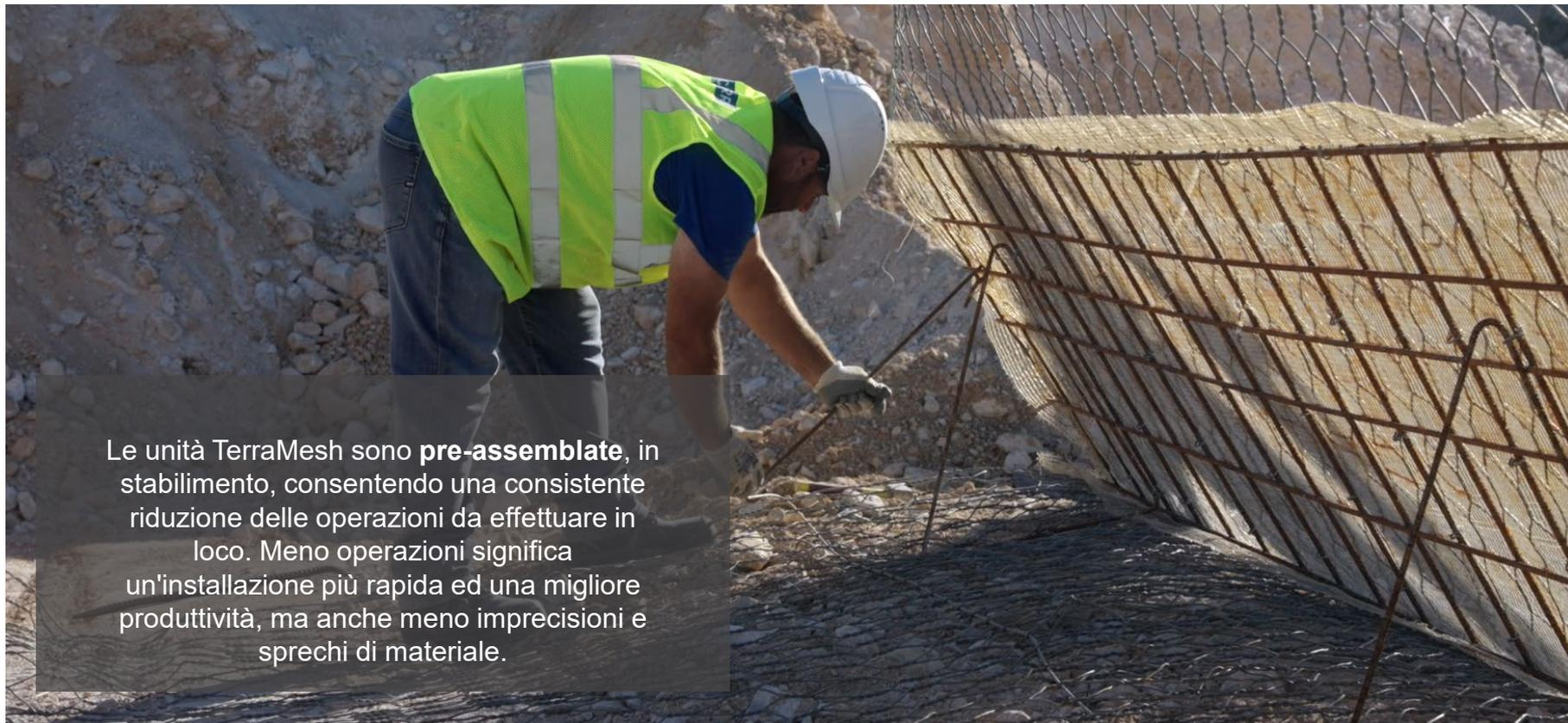
Le unità TerraMesh sono **pre-assemblate**, in stabilimento, consentendo una consistente riduzione delle operazioni da effettuare in loco. Meno operazioni significa un'installazione più rapida ed una migliore produttività, ma anche meno imprecisioni e sprechi di materiale.
